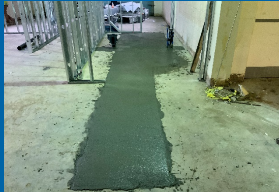
Concrete Pour at New Sanitary Trenches
